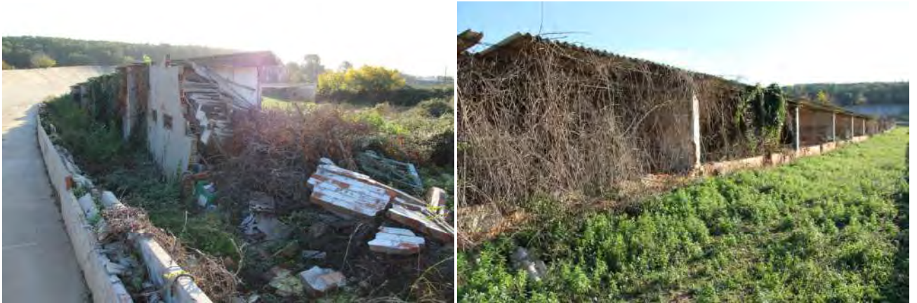
Imatge 11. Estat de les edificacions de l'antiga explotació agrícola
