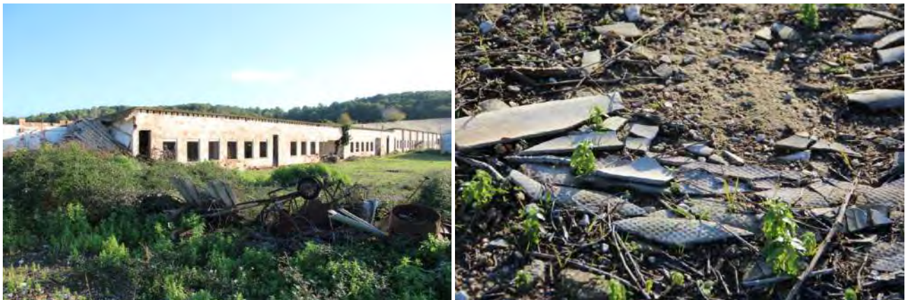
Imatge 12. Presència de residus i restes d'amiant
