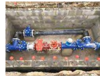
Imatge d'instal·lació tipus de reguladora
