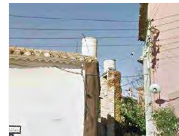
Imatge de dipòsits existents
