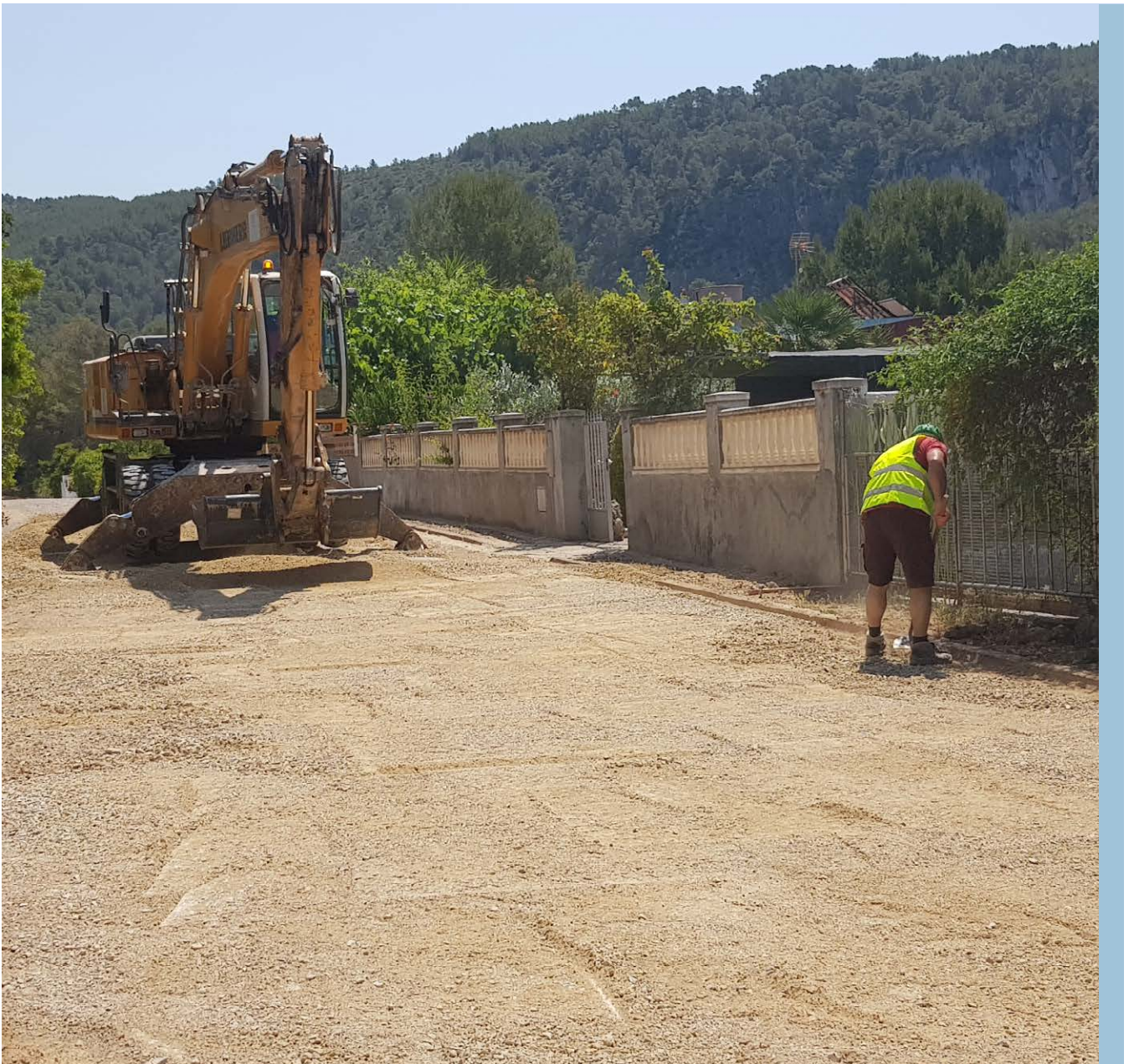
Actuació de millora de carrers i camins en urbanitzacions
