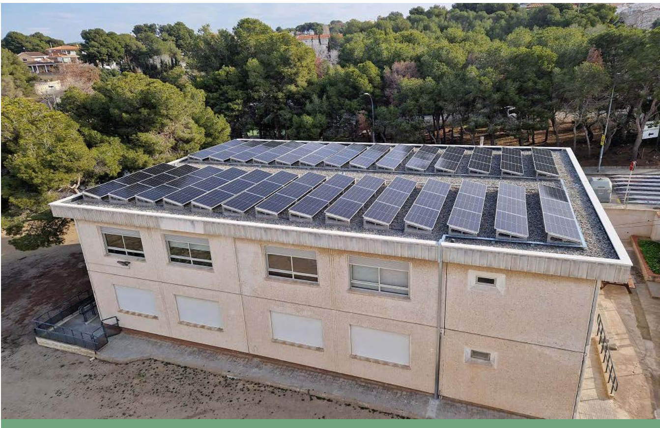
Sostres solars als equipaments municipals.
