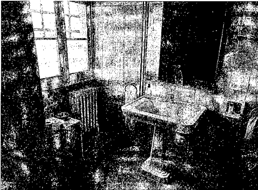
imatge d'un dels banys de planta segona.
