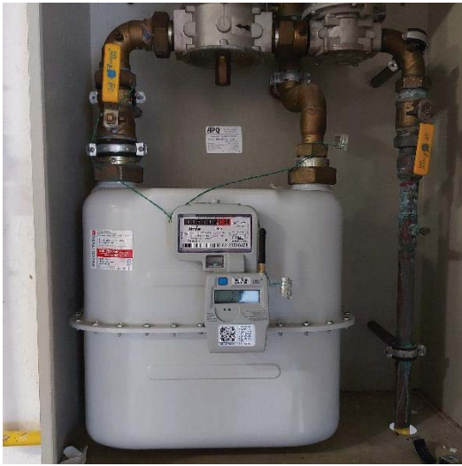
Elements instal·lació de gas natural
