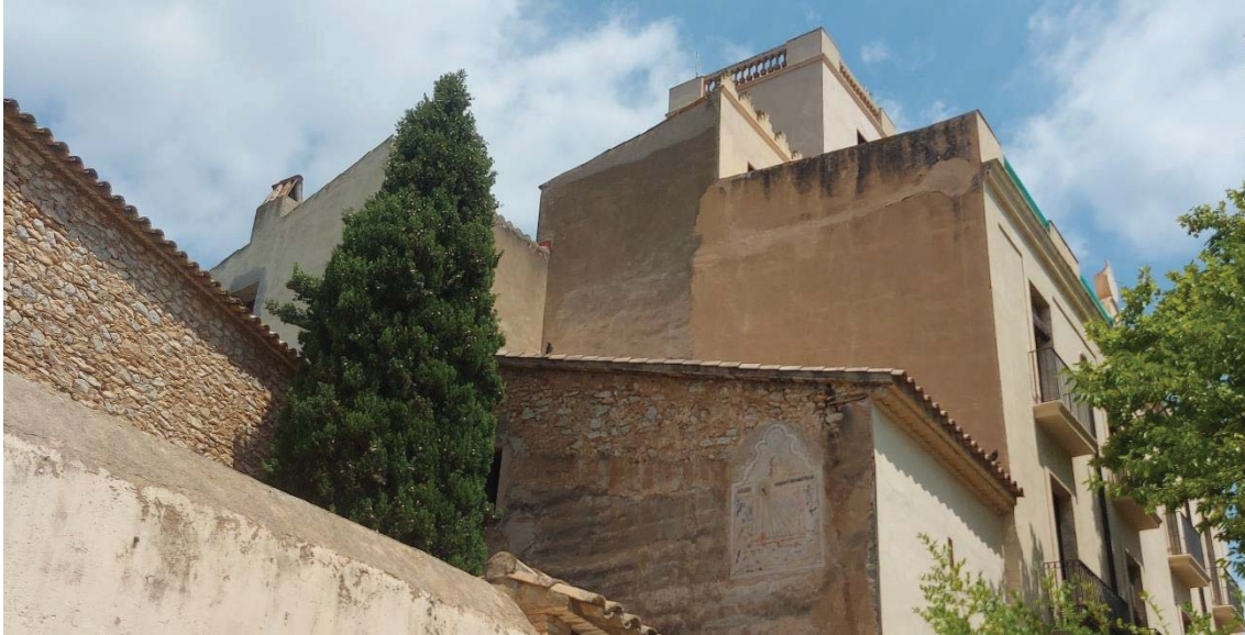
Façana lateral 4 de l'edifici
