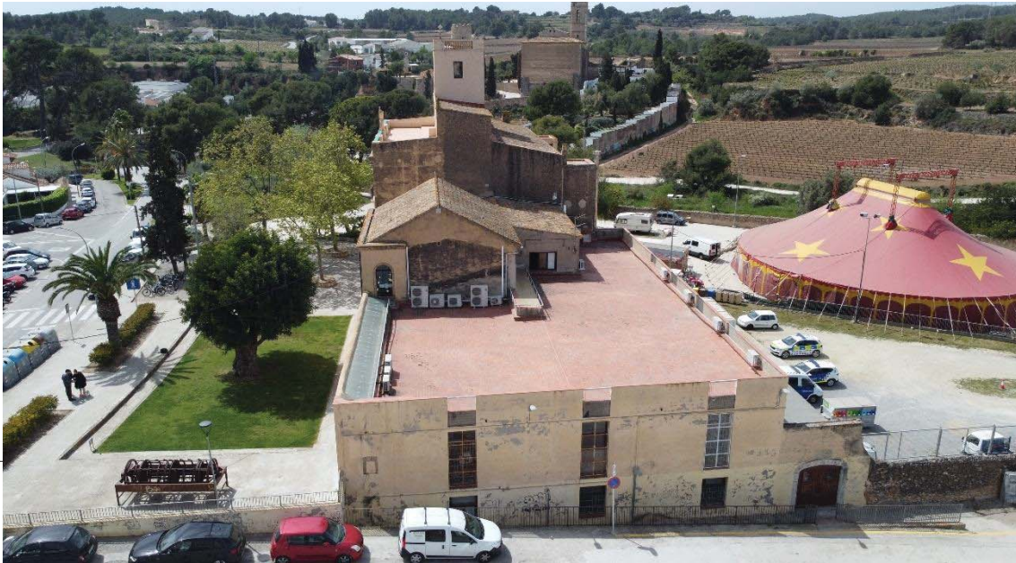
Façana lateral 3 de l'edifici
