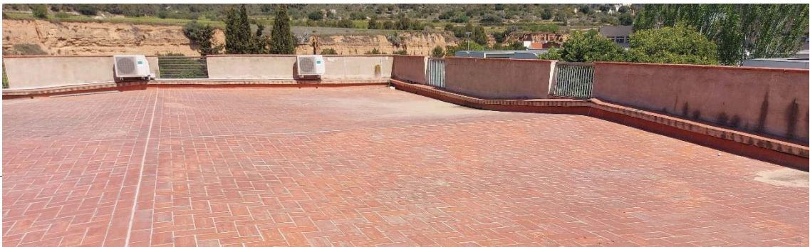
Vista parcial de la coberta plana.
