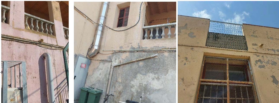
Elements instal·lació evacuació de les aigües
