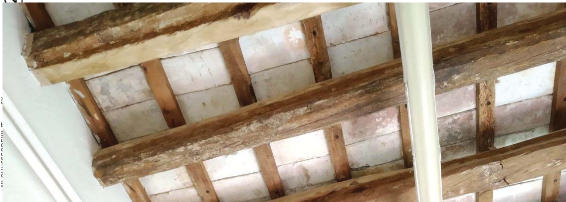
Forjat unidireccional amb bigues de fusta
