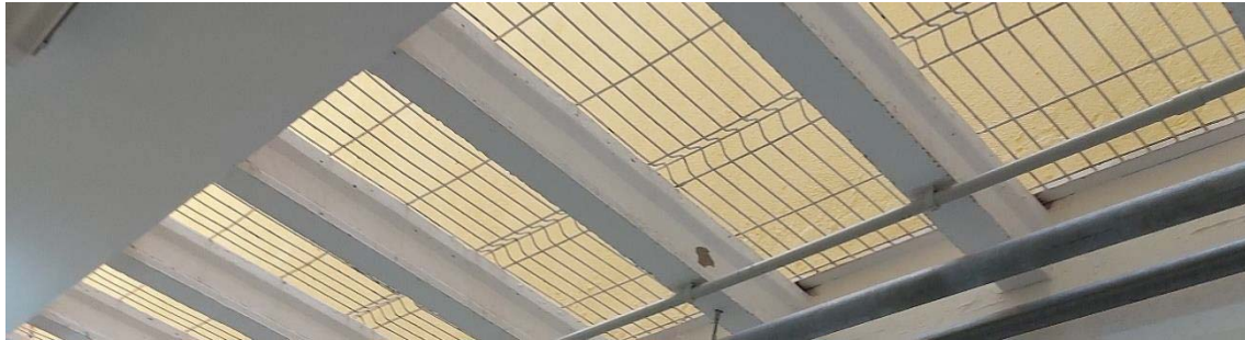
Forjat unidireccional amb biguetes de formigó
