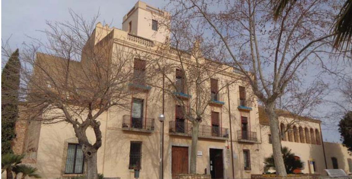
Façana principal del c/ Major.
