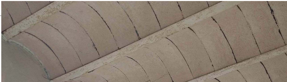
Forjat unidireccional amb biguetes metàl·liques
