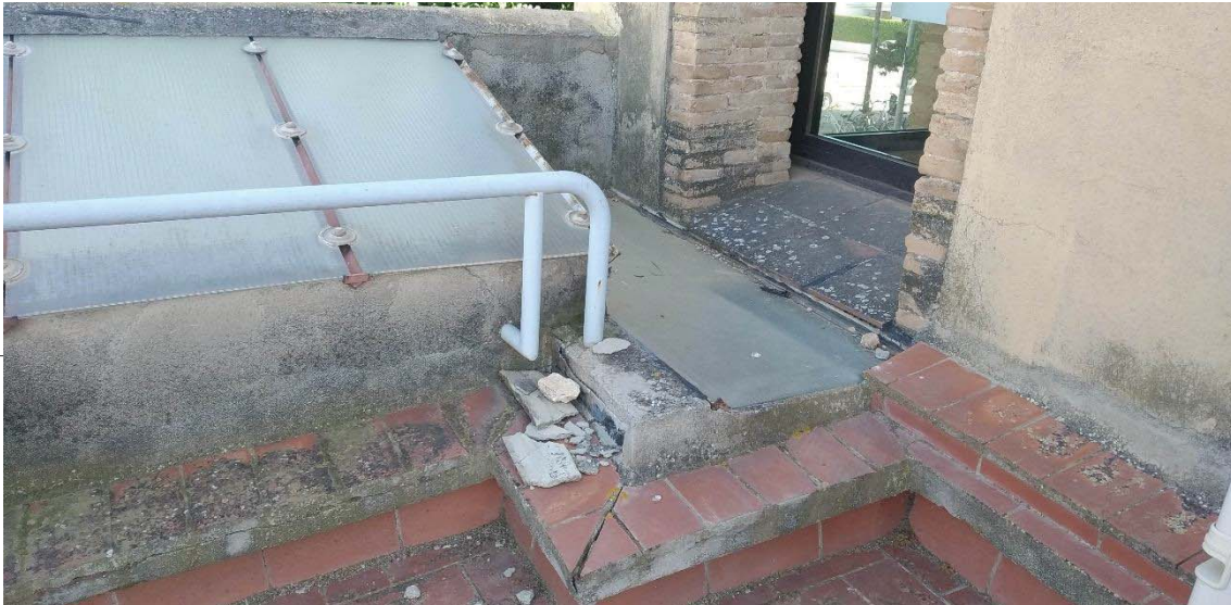
Detalls de la claraboia situada a coberta plana.
