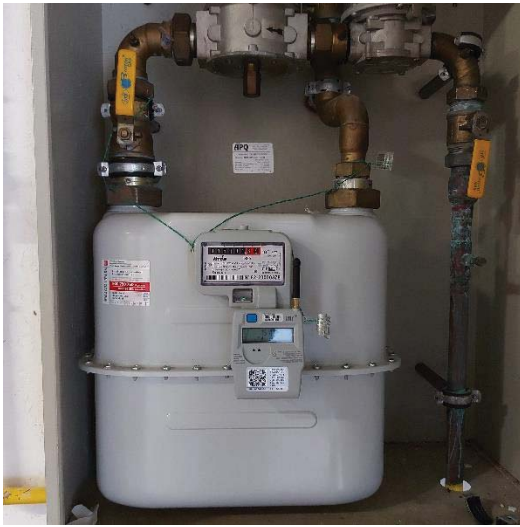
Elements instal·lació de gas natural
