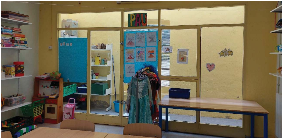
Algunes de les obertures a substituir
