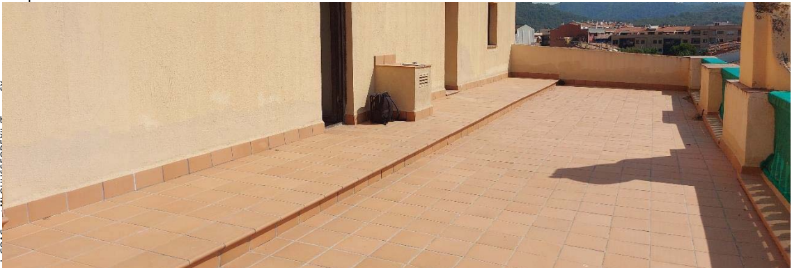
Terrassa planta tercera
