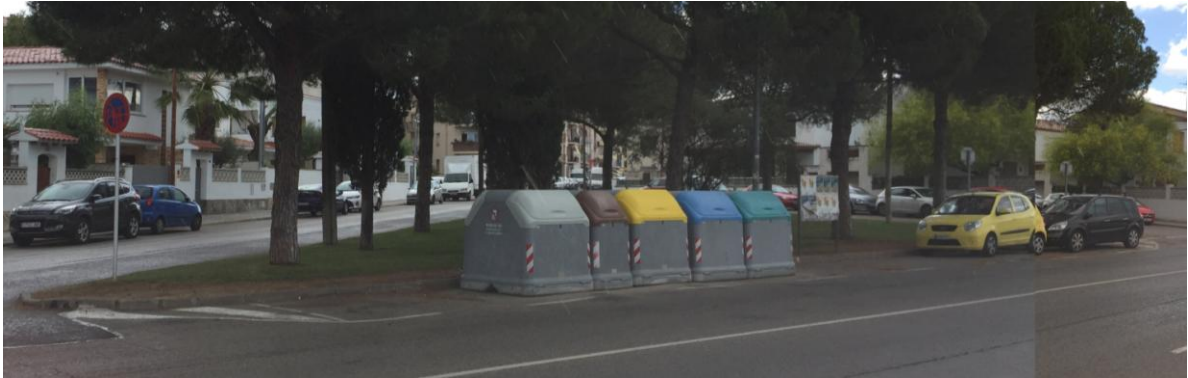
Estat actual del tram longitudinal sense vorera
