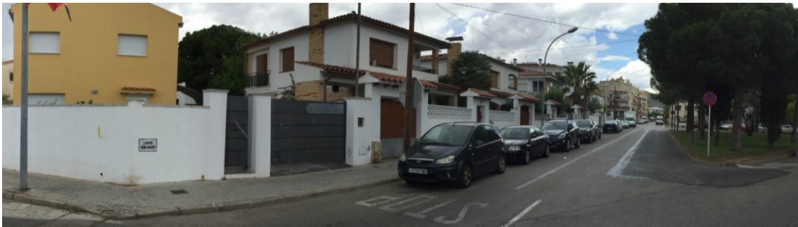
Vista general de Pas 2
